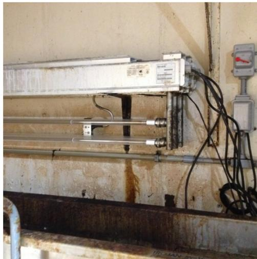
**FIGURE 5-3. ROUTE 7 WWTF UV DISINFECTION SYSTEM**
