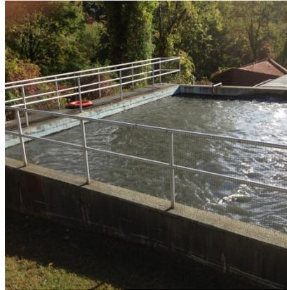
**FIGURE 5-2. ROUTE 7 WWTf EQUALIZATION TANK**
